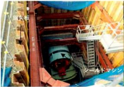
発進立坑とシールドマシン
